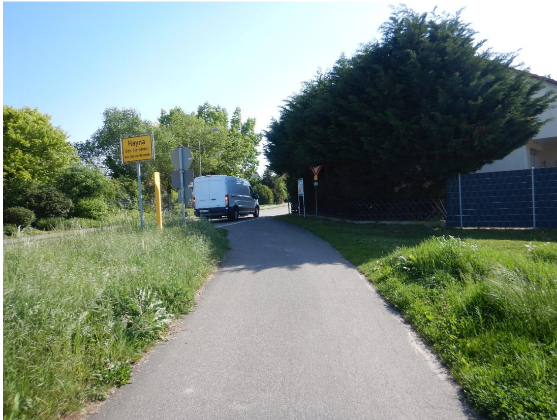
Ende eines Rad-/Wirtschaftsweges ohne geregelten Übergang auf die Fahrbahn
