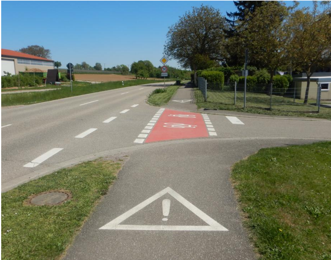
Radweg über eine Einmündung mit einer roten Furtmarkierung mit Fahrradpiktogrammen
