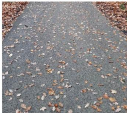
Asphaltähnliche Deckschichten aus Gemisch von Basaltstein und Speziandsen / heller Split-Mastix-Asphalt, (Quelle: Eigene Aufnahmen)
