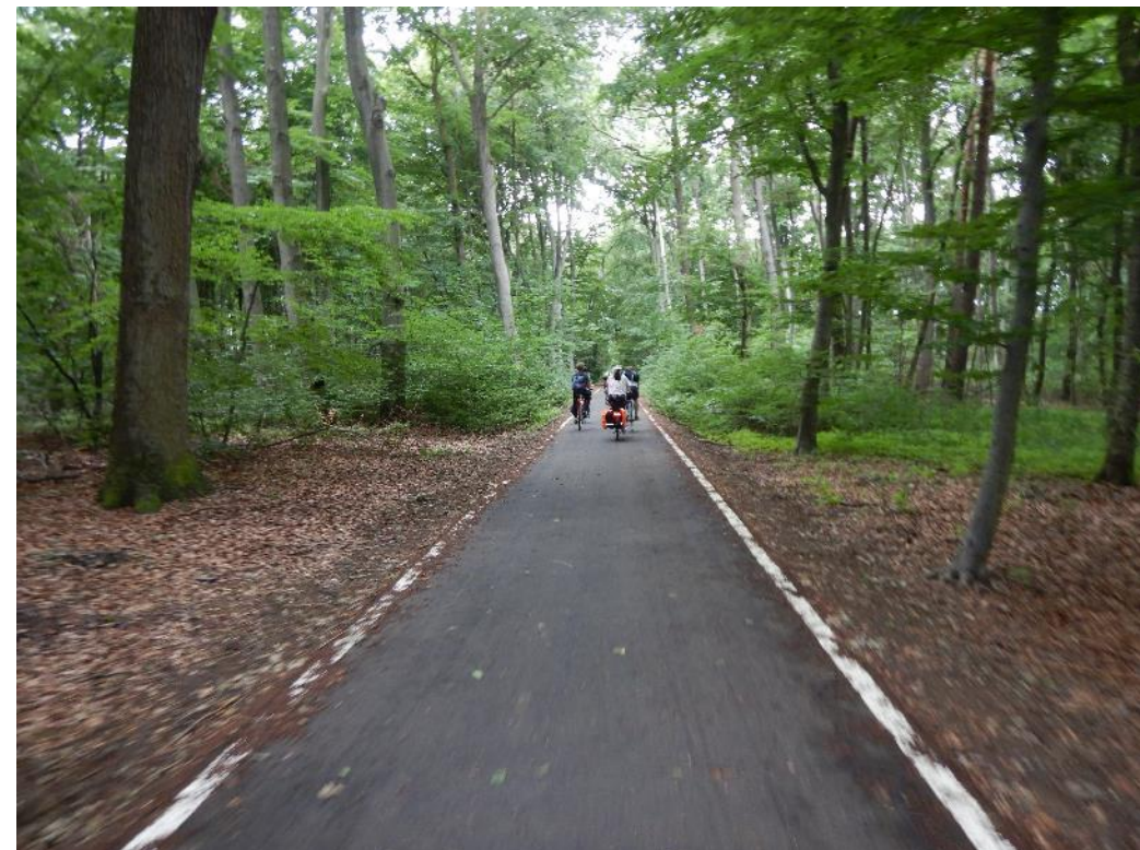
Asphaltierter Forstweg mit reflektierender Randmarkierung - Quelle: Planungsgesellschaft RV-K
