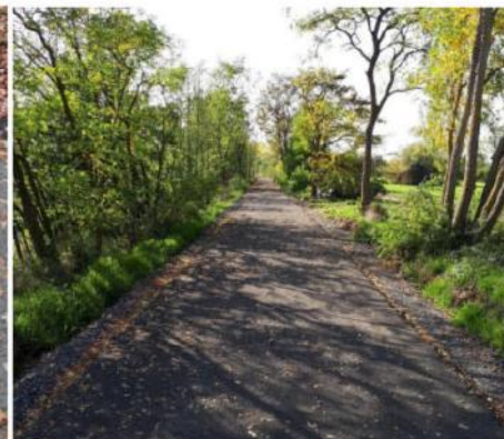
Asphaltähnliche Deckschichten aus Gemisch von Basaltstein und Speziandsen / heller Split-Mastix-Asphalt, (Quelle: Eigene Aufnahmen)
