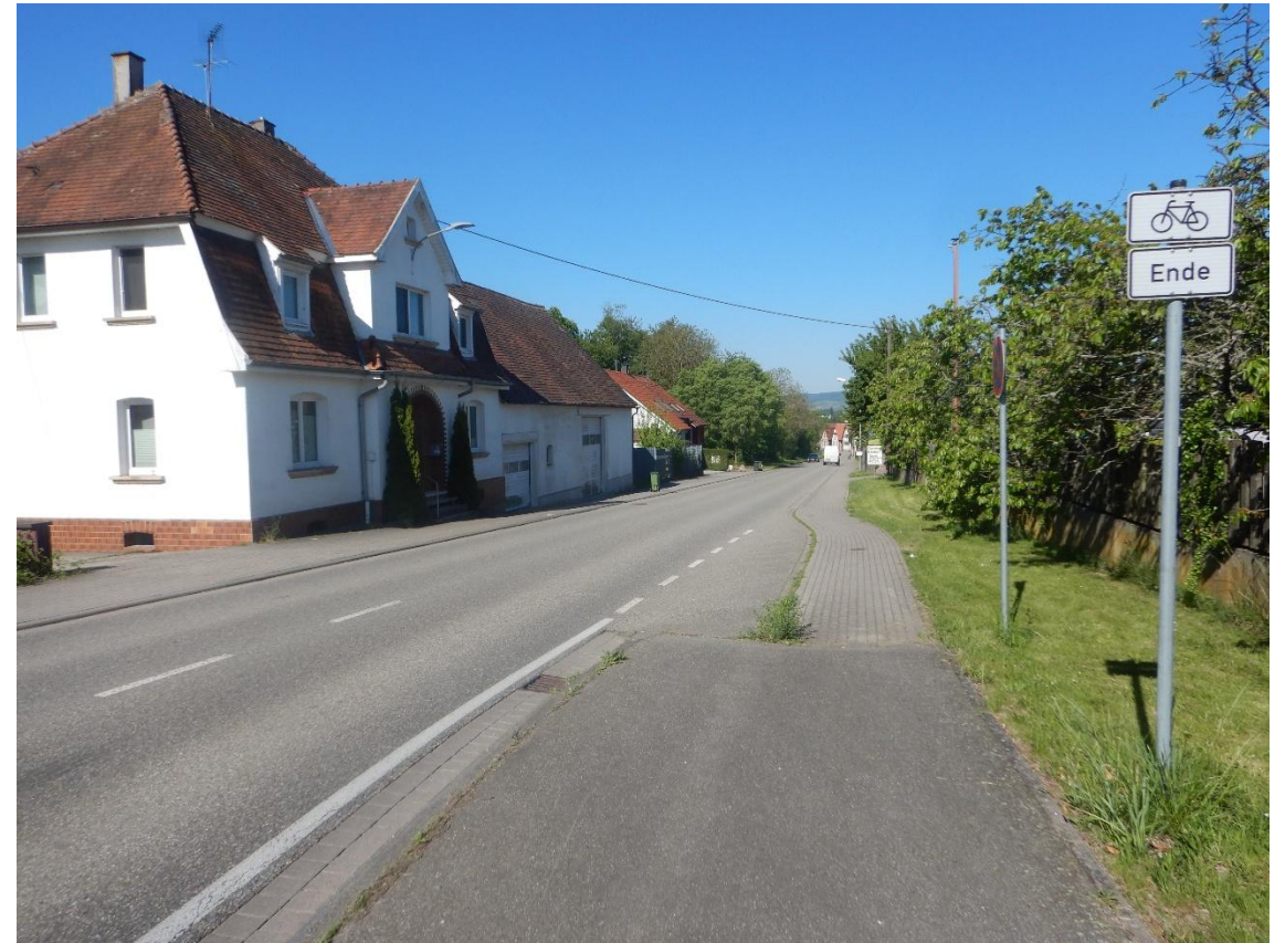
Ende eines Radweges mit Übergang auf die Fahrbahn
