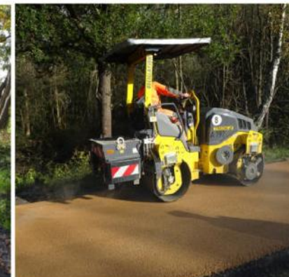
Asphaltähnliche Deckschichten aus Gemisch von Basaltstein und Speziandsen / heller Split-Mastix-Asphalt, (Quelle: Eigene Aufnahmen)
