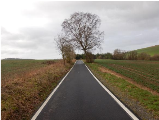
Asphaltierter Wirtschaftsweg mit Randmarkierung (eigene Aufnahme)
