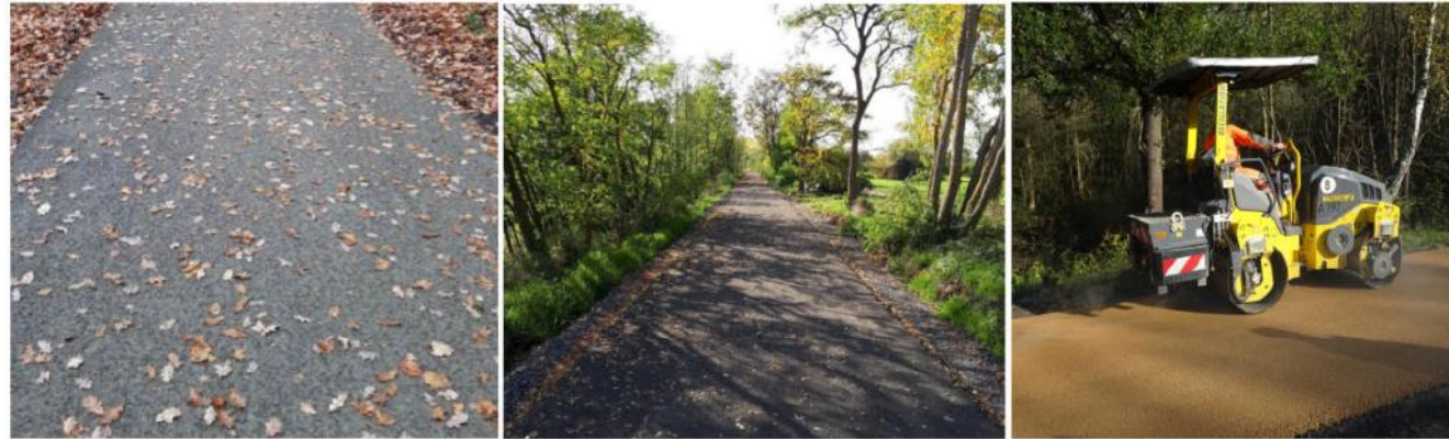
Asphaltähnliche Deckschichten aus Gemisch von Basaltstein und Spezialsanden / heller Split-Mastix-Asphalt, (eigene Aufnahmen)
