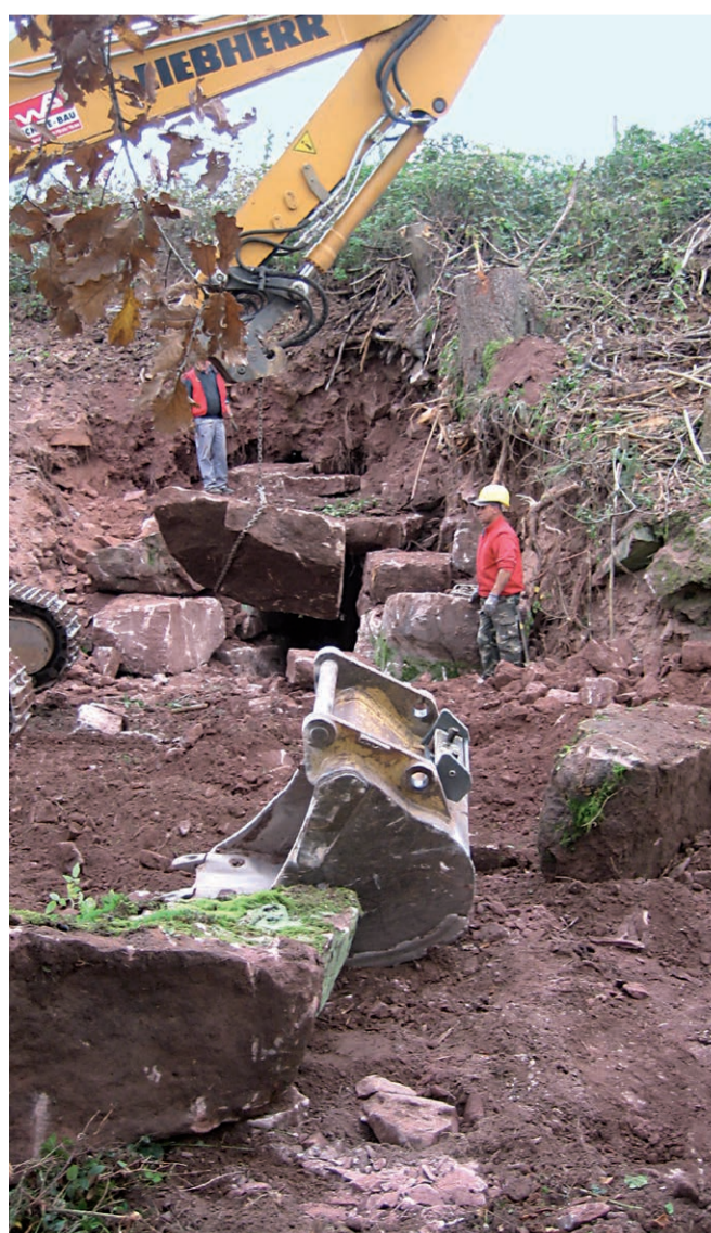
Öffnung des St. Georg Stollens Neubulach-Liebelsberg als Winterquartier für Fledermäuse
